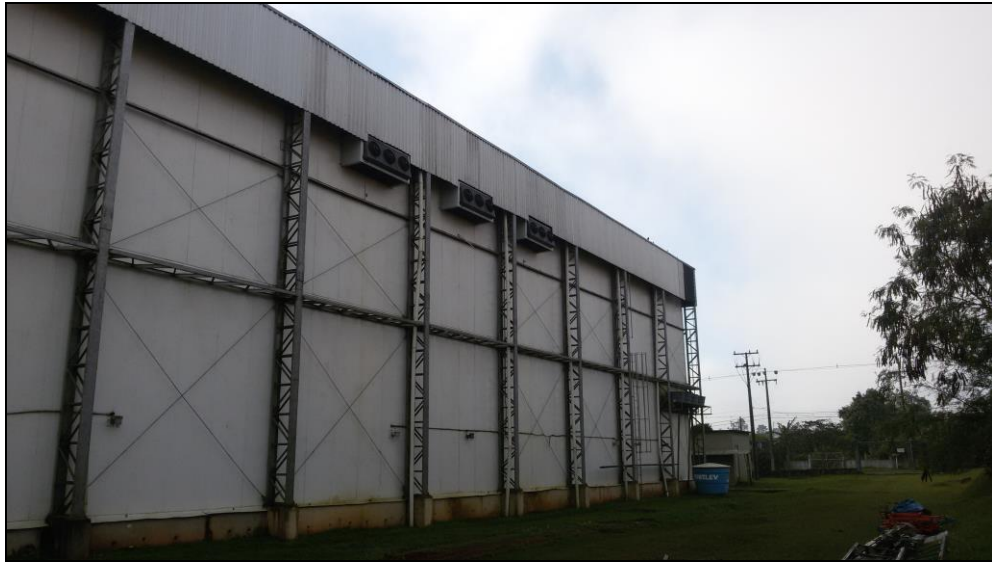
FIGURA 2 – DETALHAMENTO DO PONTO DE MEDIÇÃO 01, COM DETALHE PARA OS 03 APARELHOS DE REFRIGERAÇÃO
